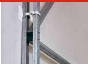
I montanti sono costituiti da due profili accoppiati, per avere sezioni resistenti e soprattutto rigide. Si aumenta così l'inerzia statica, riducendo la deformabilità dei montanti stessi. Tra i profili vengono inserite le diagonali, i distanziali delle strutture e, in basso, la ruota con gli agganci per il sistema antideragliamento.
