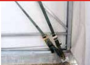
Diversamente dai competitor, per tensionare e ancorare la copertura in PVC al suolo ci si avvale di robuste cinghie di trazione certificate e marchiate CE con carico di rottura pari a 5000 kg. Totalmente esenti da problemi di corrosione, sono molto semplici da tensionare periodicamente e hanno una elevata tenacità, per evitare rotture improvvise.
